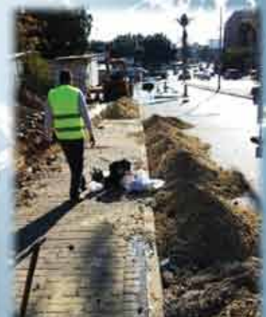
החלפת קו מים ראשי בשד' לכיש
